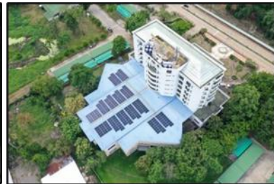
อาคารสำนักงานอธิการบดี 113.4 kWp
